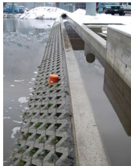
Mise en eau de la prairie
