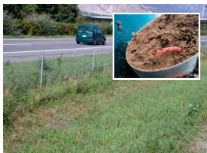
Fossé d'infiltration en vignette: Carottage sur site d'infiltration
