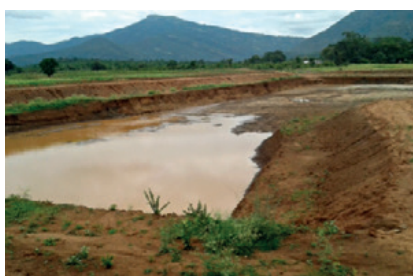
Récupération des eaux de pluies
